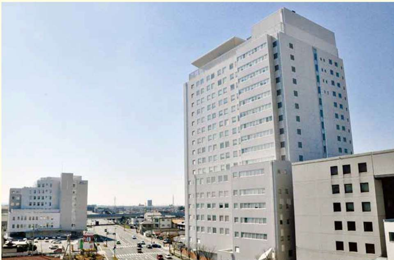
国道 209 号沿いに建つ地上 19 階、地下 2 階の聖マリア病院地域医療支援棟。免震機能やヘリポートなど災害拠点病院として不可欠の能力を備えています。左は聖マリアヘルスケアセンター
